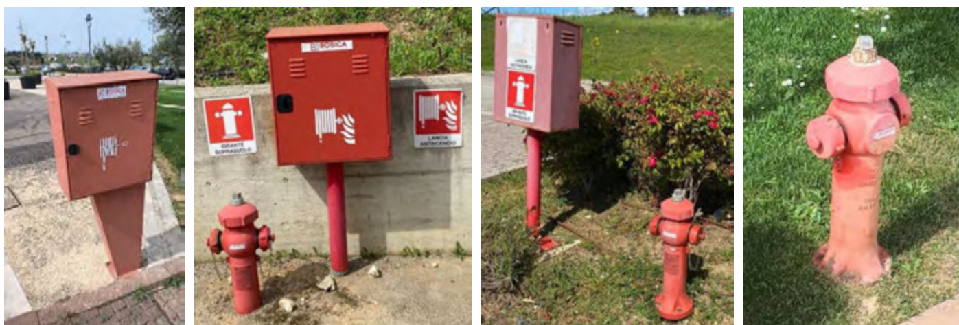
Figura 23: Idranti UNI70 area esterna
