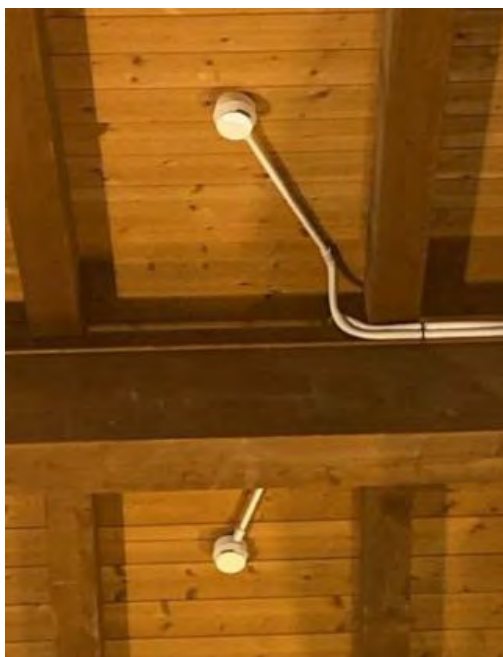
Figura 32: Impianti di rilevazione fumi e centralina
