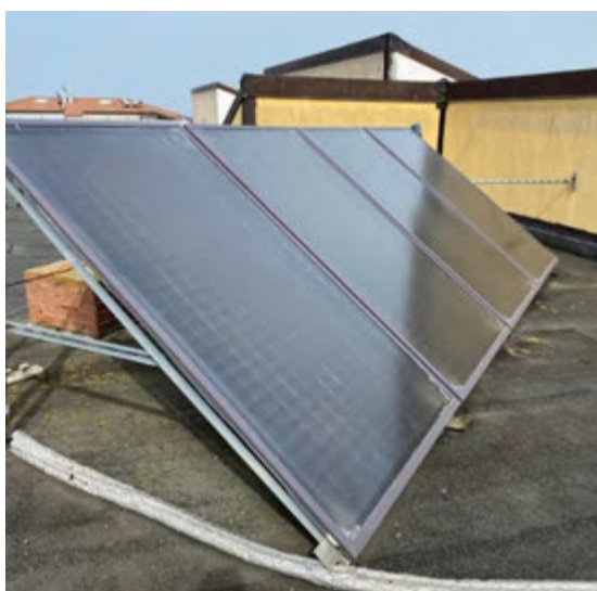
Figura 20: Sistema del solare termico bagni pubblici
