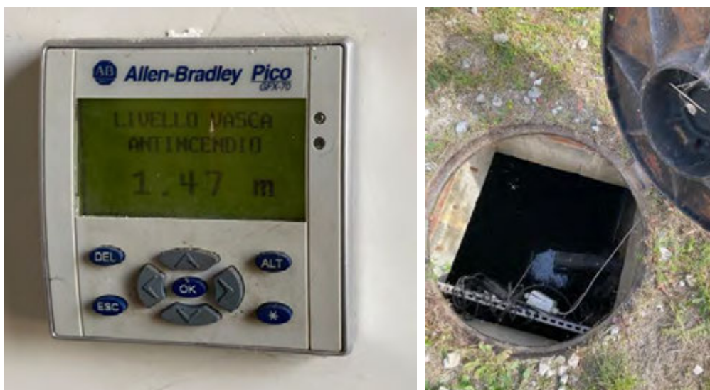
Figura 27: Dispositivo che indica il livello della vasca antincendio e chiusino d'ispezione
