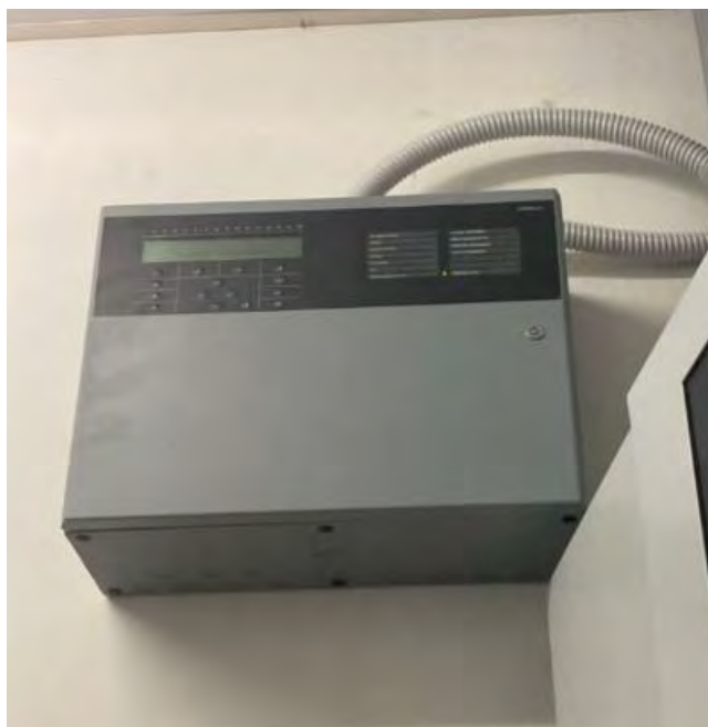
Figura 32: Impianti di rilevazione fumi e centralina
