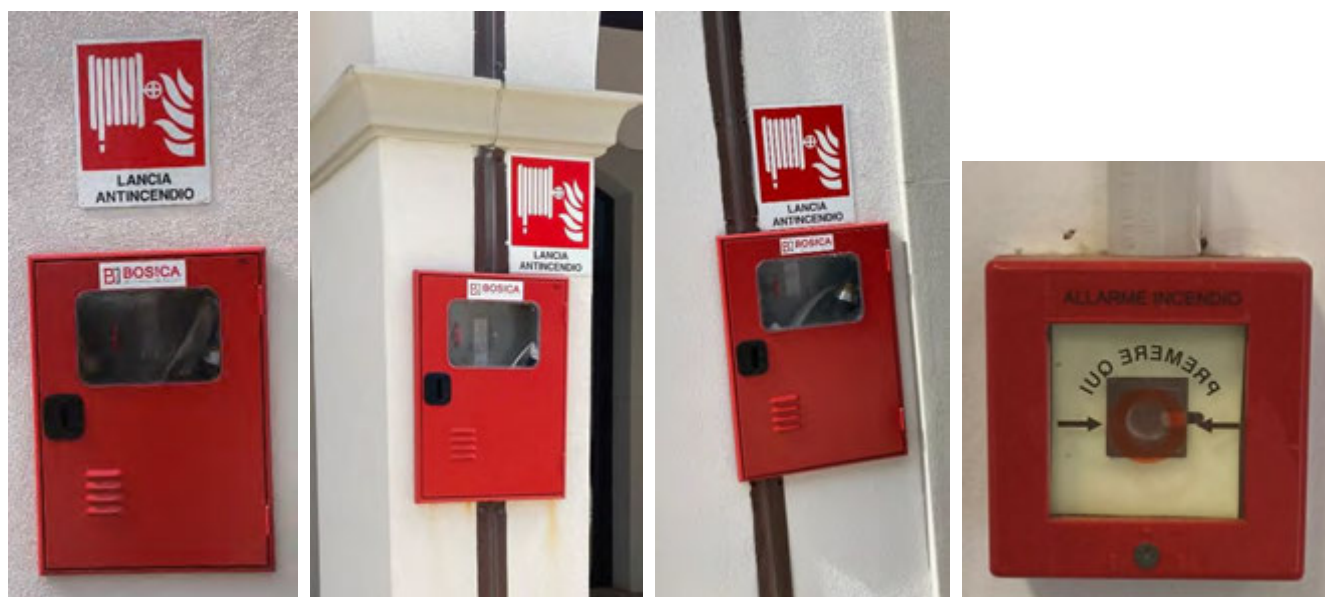
Figura 22: Idranti viale UNI45 e allarme antincendio
