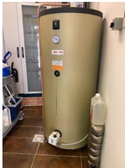
Figura 20: Sistema del solare termico bagni pubblici
