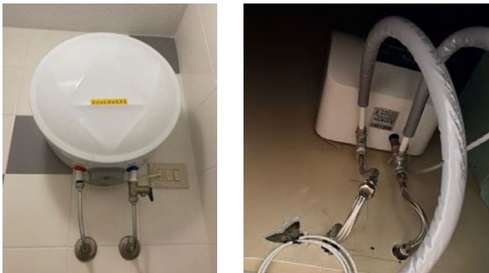
Figura 21: Boiler per ACS
